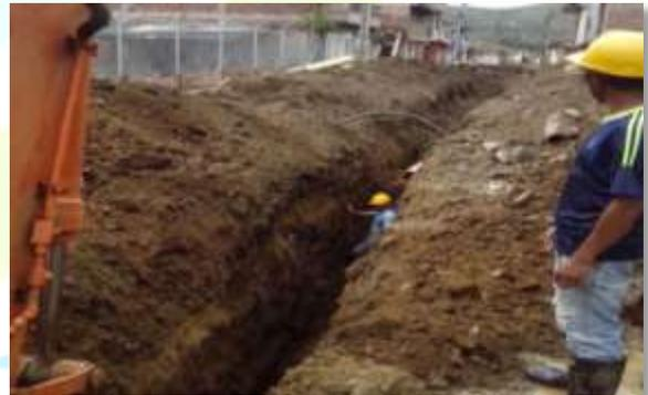
EXCAVACIÓN PARA INSTALACIÓN DE TUBERIA PVC SANITARIA
