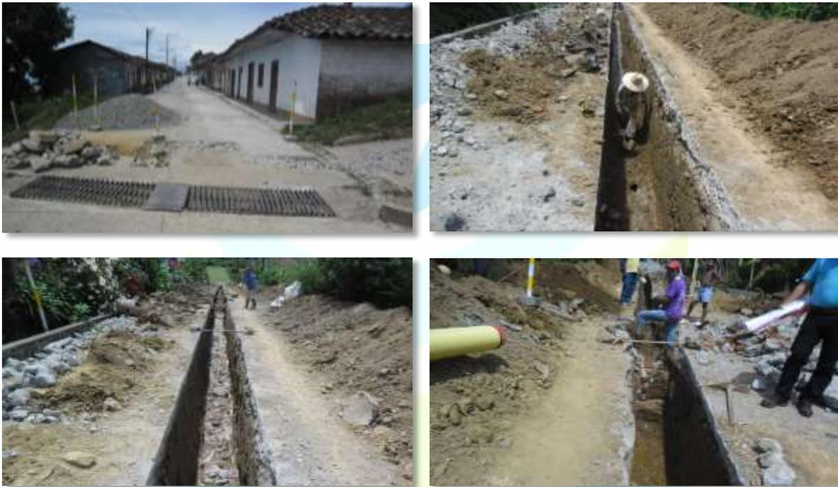
Corte de pavimento / Instalación tubería principal / Excavación para la tubería principal
