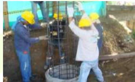
Excavación e Instalación de encamisado para Caissons / Instalación de refuerzo en Caissons
