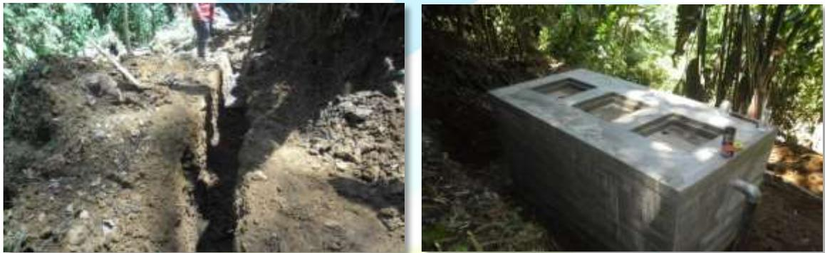
Excavación para instalación tubería / Reconstrucción desarenador
