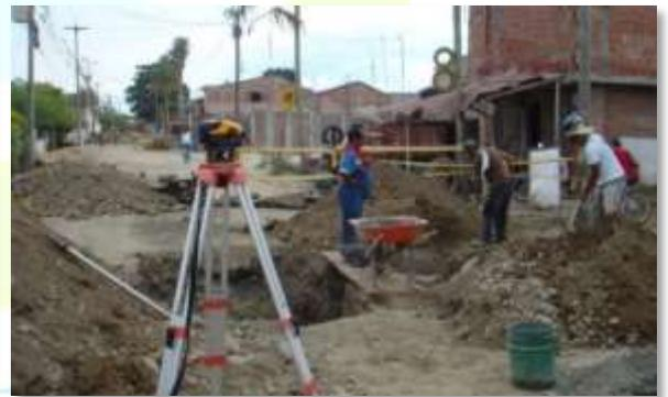
Relleno de material filtrante / Cámaras / Instalación tubería y accesorios / Topografía
